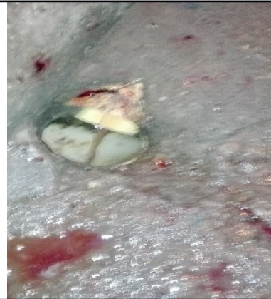
Foto No. 6 Presunta tubería de agua lluvia procedente de segundo nivel con descarga de ARND generada del lavado de áreas, utensilios, equipos e instalaciones.
